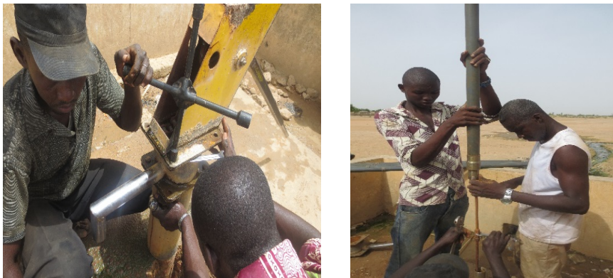
Démontage et remontage du système existant : Cscm de Komola-Zanfina
